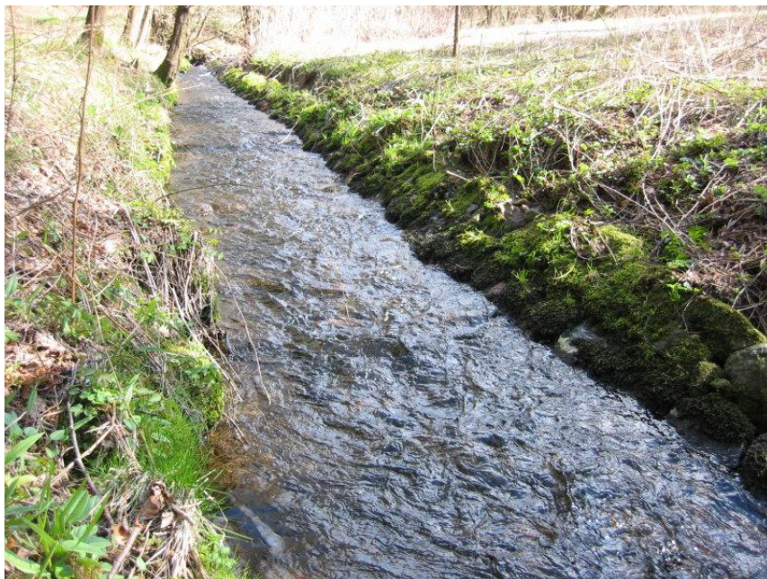
Begradigung der Daade zwischen Stauwerk 3 und 4.
