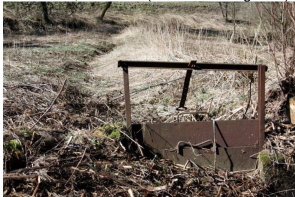
Stauwerk 5; Einlass 9 (in Fließrichtung links)
