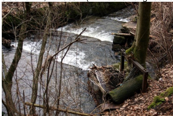
Stauwerk 4; Einlass 7 (in Fließrichtung rechts)
