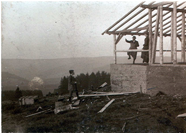
Das Balkengerüst der „Siegfriedhütte“ ist errichtet.
