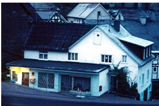
Die Emmerzhäuser Poststelle im Haus von Egon Kober im Februar 1995.
