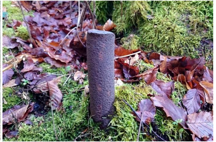
Links: Guterhaltenes Fundament einer Dampfmaschine im Bereich des ehemaligen Kesselhauses. Rechts: An solchen, heute noch vorhandenen, Bolzen war die Dampfmaschine befestigt.
