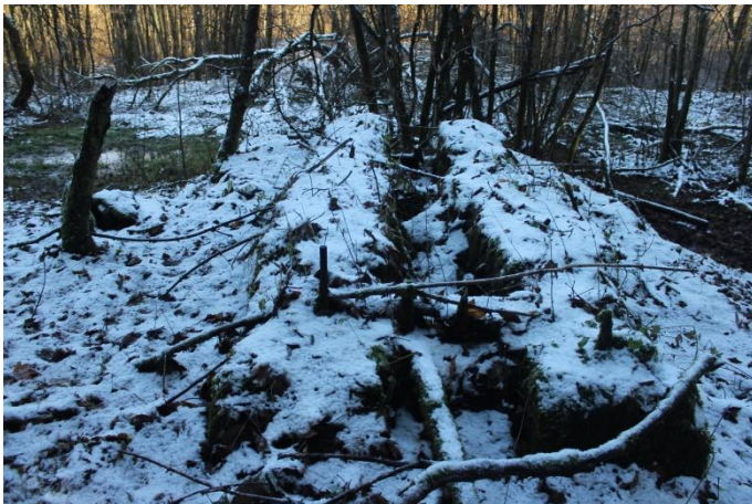
Rechts oberhalb vom Geländeeinschnitt sind die Fundamentrest der Umlenkrollen (links) der Brems- und Schleppbahn noch gut zu erkennen. Besonders die Gewindestangen sind noch sehr gut erhalten. Direkt vor dem Geländeeinschnitt ist ein großes Plateau (rechts) entstanden, welches überwiegend aus Abraum besteht. Hier wurde das Material von der Feldbahn auf die Brems- und Schleppbahn umgeladen.
