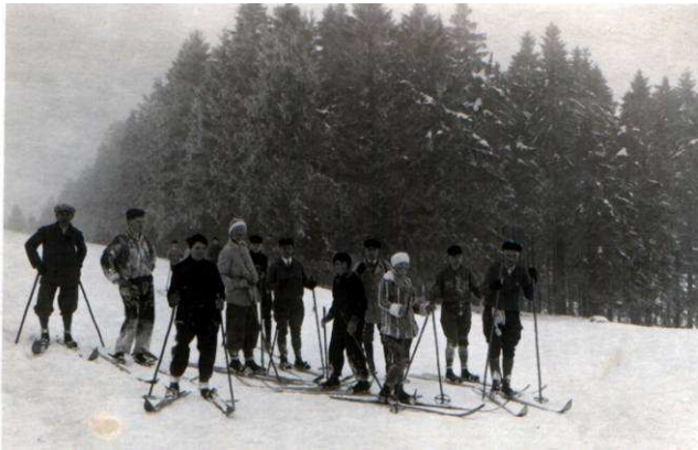
Skifahrer im Bereich der Daadequelle.
