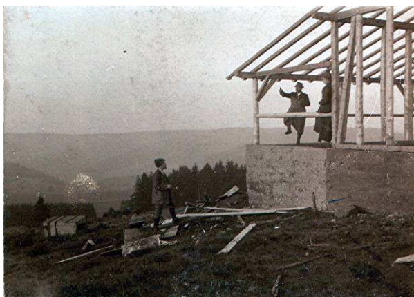
Richtfest an der neuen Siegfriedhütte.
